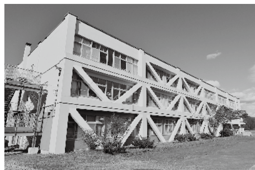
耐震改修された青葉小学校
