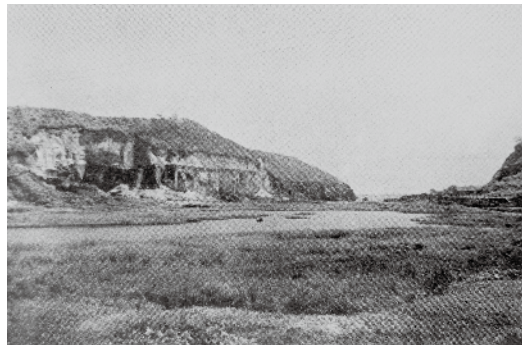
登別漁港建設予定地（昭和25年頃撮影）
