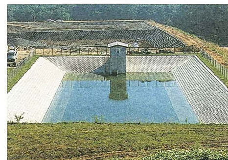
浸出水調整池
