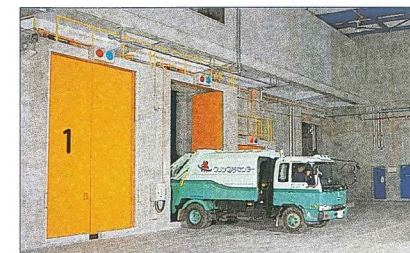
プラットフォーム 計量されたごみは、ごみビットに投入します。
