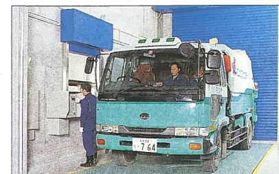
計量機(トラックスケール) 収集されてきたごみを、入場時に計量・記録し、集計管理します。
