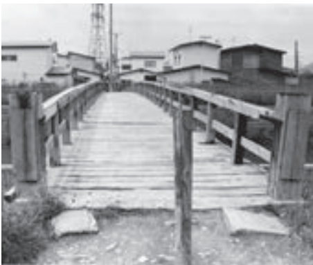
▲新鷺別橋が架けられる前に利用されていた鷺別人道橋
