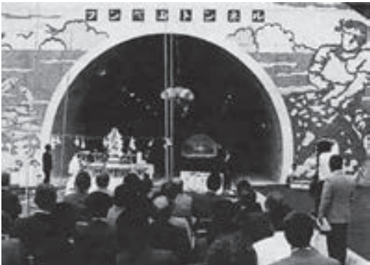
▲『フンベ山トンネル』の開通式
