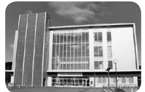
▲建替工事が完了した『鷺別小学校』
