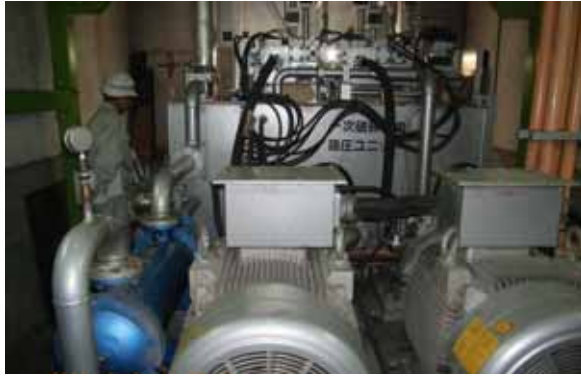
写真 13 一次破碎機用油圧ユニット
