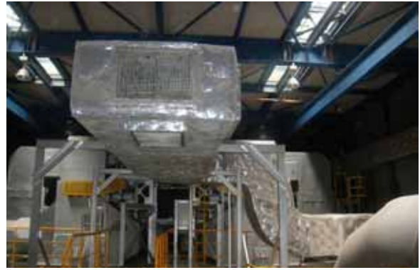
写真10 焼却施設上部
