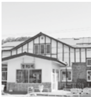
▲エレベーター設置に向けた協議が進むJR登別駅
