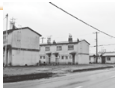
▲平成30年度から建て替え工事を始める千代の台団地
