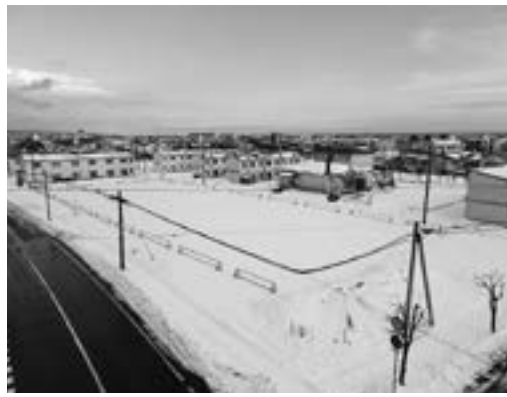
▲千代の台団地の建て替えに当たり、解体工事が完了した敷地
