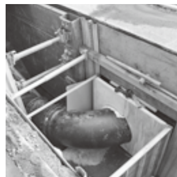
▲道路冠水を軽減させるため、計画的に実施している排水路整備
