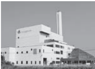
▲老朽化した焼却処理施設や破碎・資源化処理施設の設備などを更新しながら、運営をしているクリニクルセンター
