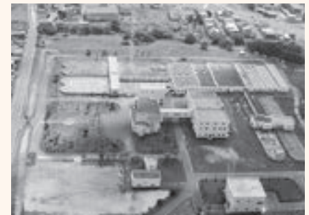
▲生活排水の処理を行う若山浄化センター
