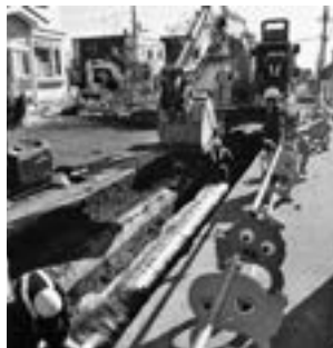
▲道路排水対策（雨水対策）工事
