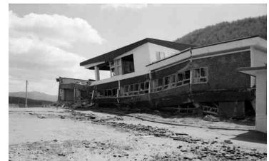
半倒壊した病院
