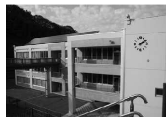
室蘭市 星蘭中学校太陽光パネル
