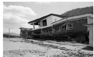
半倒壊した病院
