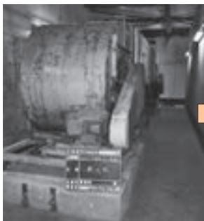
▲焼却炉を設置している炉室内に空気を送り込む給気ファン
