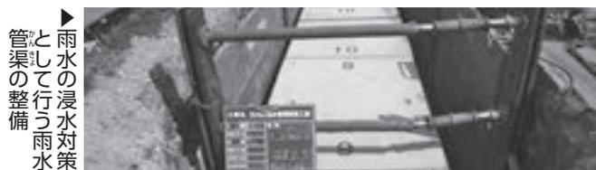
雨水の浸水対策として雨水管渠の整備
