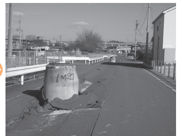
▲震災で1メートル以上隆起したマンホール（右）も元通りに復旧（左） [写真提供 白石市]
