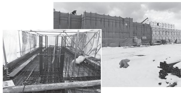
▲建て替え中の鷺別小学校。4階建てで、屋上は海拔約21㍍となる予定
