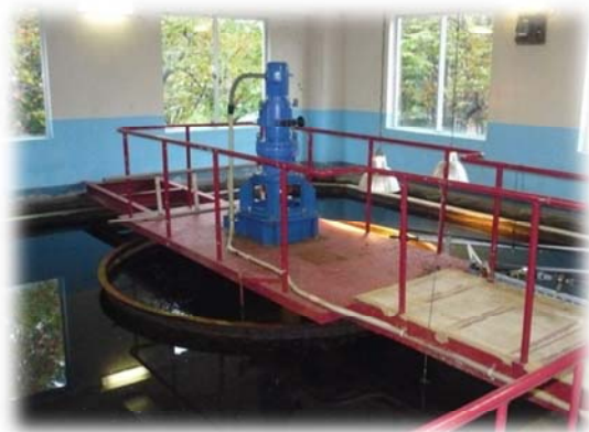
～写真（登別温泉浄水場取水口周辺／幌別浄水場高速凝集沈澱池）～
