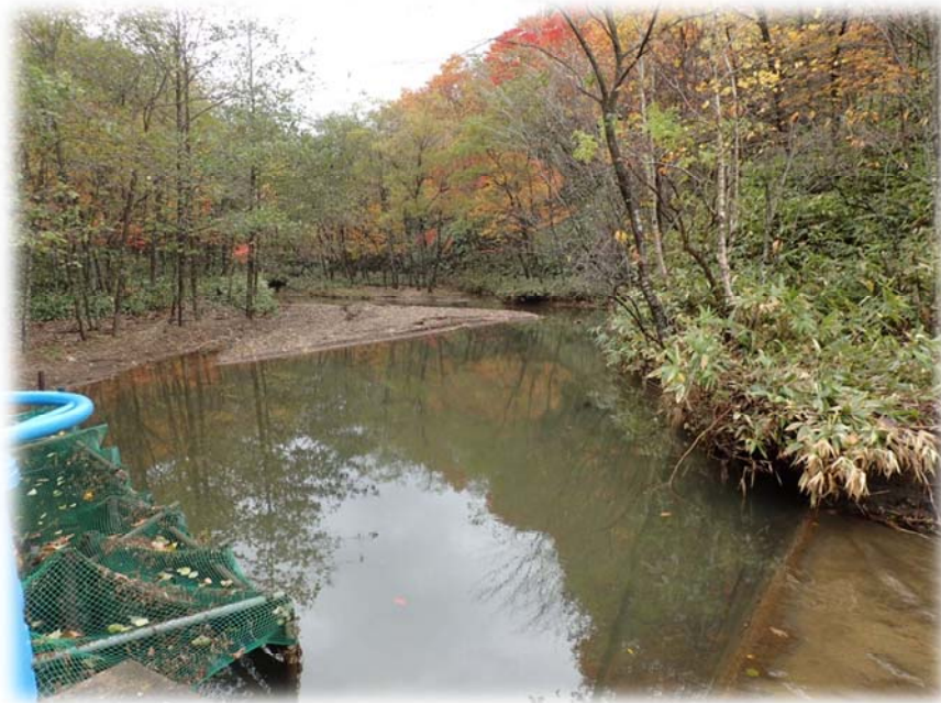
クスリサンベツ川水源地（登別温泉浄水場 取水口）
