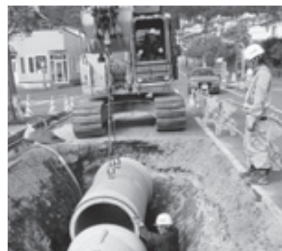
▲道路排水対策（雨水対策）工事
