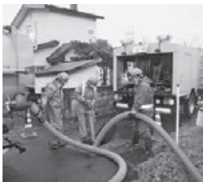
▲既設排水路の清掃作業
