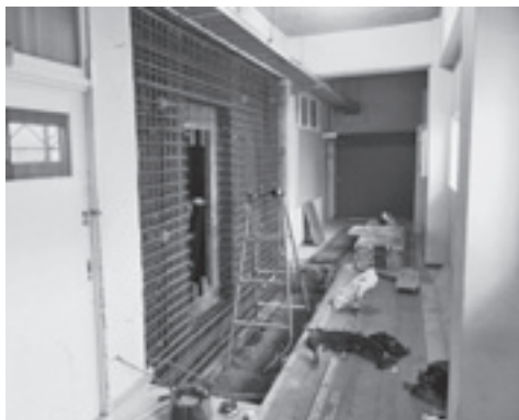
▲校舎内部の耐震化工事（鷺別中学校）
