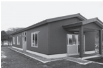
▲休憩施設（外観）
