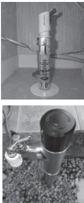
▲水抜き栓の種類の一例
