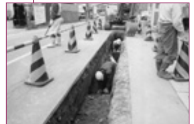
▲配水管改良工事
