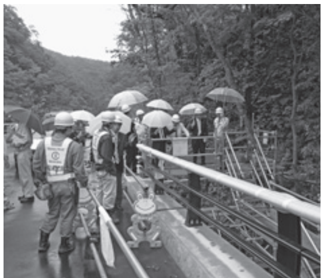
▲道道改良工事現地視察の様子
