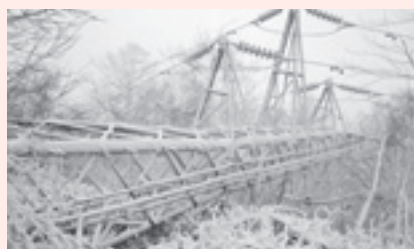
▲倒壊した電線鉄塔
