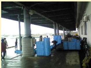
【屋根付き岸壁】
