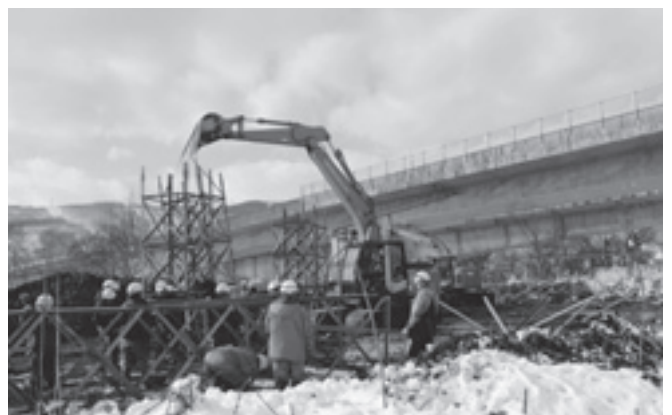
▲建設中の北海道電力仮鉄塔
