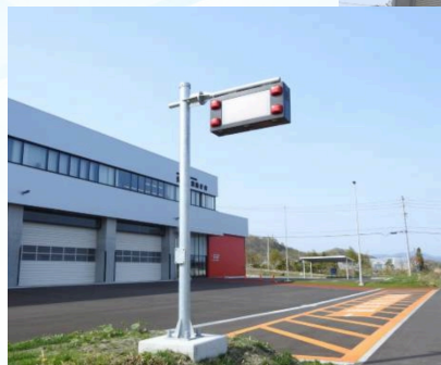
▲出動表示灯は、緊急車両の出動約1分前に文字と点滅で周囲に知らせます。
