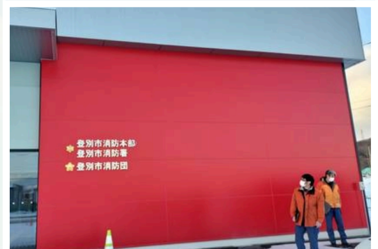
▲ 消防庁舎の正面玄関に消防車の朱色と同色を用い、消防施設と一目で分かるデザインを採用しています。
