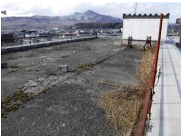
老朽化等により剥離やひび割れなどが発生している 現庁舎屋上
