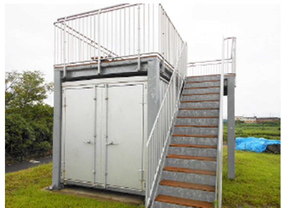
防災公園内展望台付き防災倉庫（新潟県燕市）
