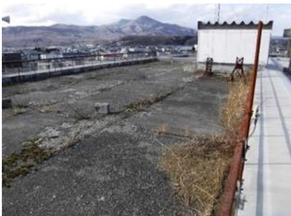
老朽化等により剥離やひび割れなどが発生している
