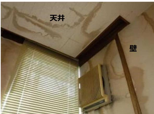
現庁舎内で慢性的に雨漏りが発生し、雨漏りで壁クロスが変色
