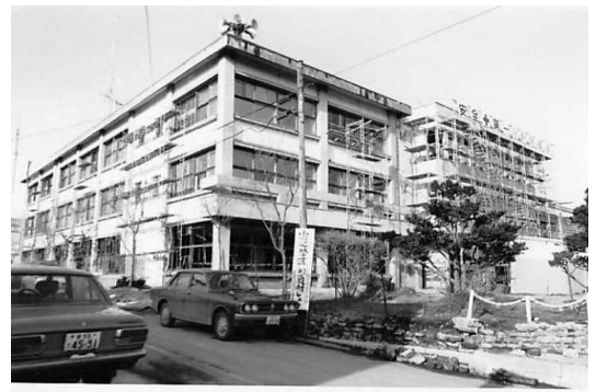
昭和49年本庁舎増築工
