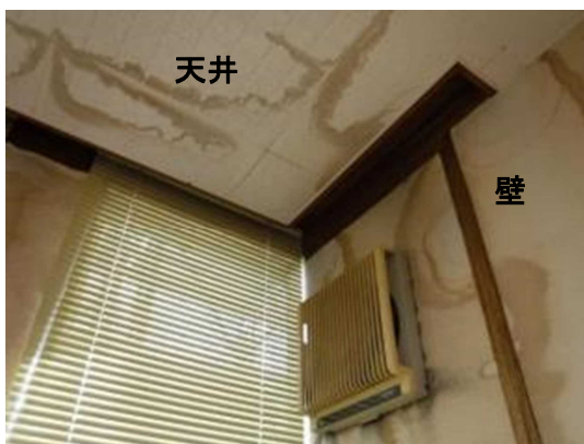
【写-12】庁舎内で慢性的に雨漏りが発生し、市長室においてももの雨漏りで壁クロスが変色
