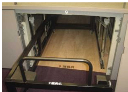
【写-40】 参考 机等は可動式で収納できる。壁も取り外し可能であり議会以外の活用も可能。（新潟県新発田市）
