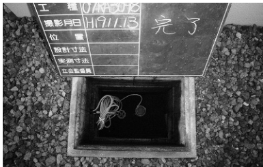
▲水道メーター取り替え工事
