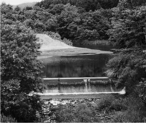
▲幌別浄水場取水口
