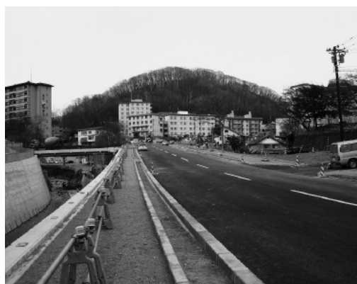
▲整備が進む温泉バイパス
