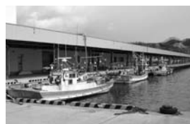
▲登別漁港屋根付岸壁
