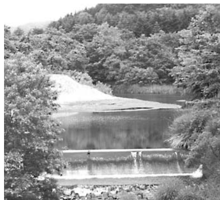
▲幌別浄水場取水口
