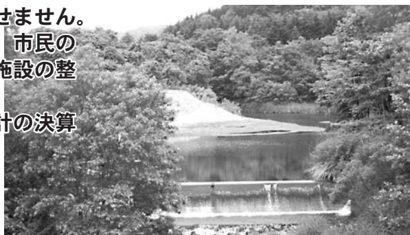
▲幌別浄水場取水口
