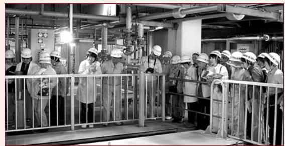
▲若山浄化センター
