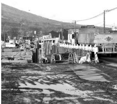
▲拡幅工事中の国道36号
