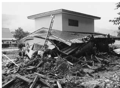
▲土砂崩れ（昭和55年・片倉町）
