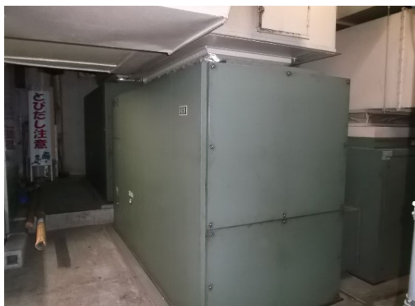
老朽化したボイラー設備
