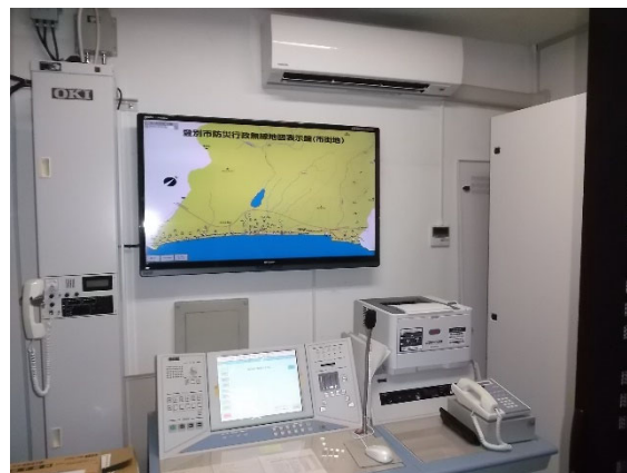
防災行政無線システム
