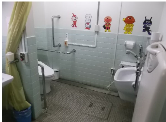
多目的トイレ（1階のみ設置）
