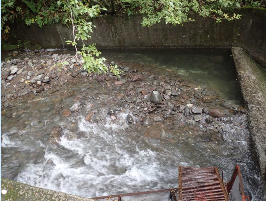
取水口閉塞状況
