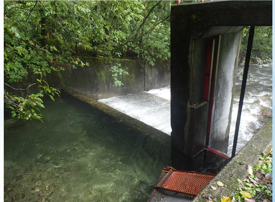
取水口清掃後
