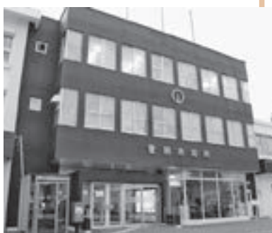
▲老朽化が進む市役所の本庁舎
