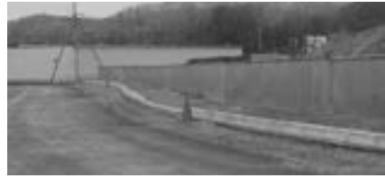
▲道路整備が進む登別東町
