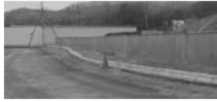
▲道路整備が進む登別東町
