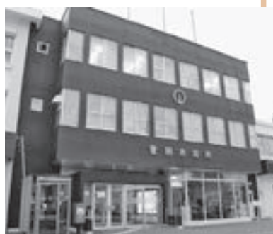
▲老朽化が進む市役所の本庁舎
