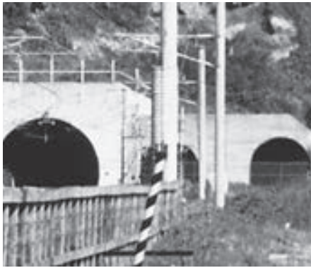
▲明治期のトンネル(右)と昭和55年完成のトンネル(左)
