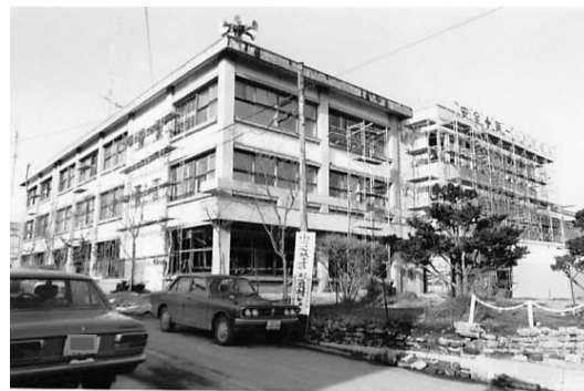
昭和49年本庁舎増築工事
