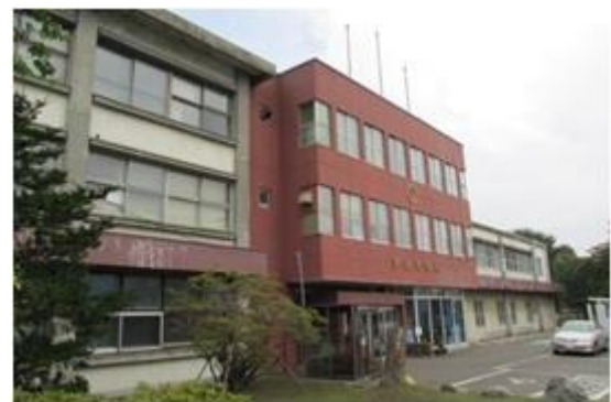
【写-7】 改修前の本庁舎
