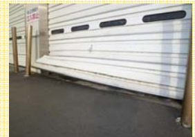
【活魚施設の破損・故障】
