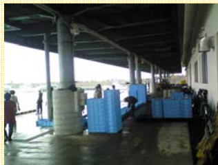
【屋根付き岸壁】
