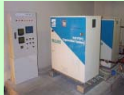
(写真)電力を供給するとともに排熱を給湯・暖房に利用(北大)
