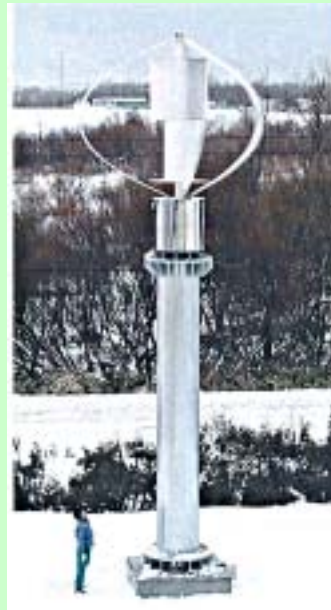
（写真）石狩中に設置された風力発電装置（10kW、高さは基部も含めて約11.5m）
