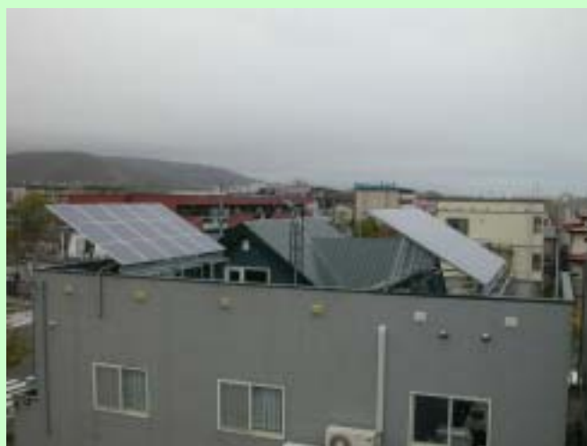
(写真) システム出力 4.35kW (傾斜角度 30度) 設置面積 28.8m 2
