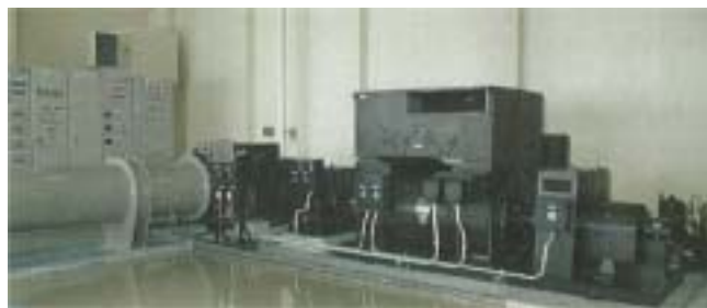
(写真) 発電機室内部
