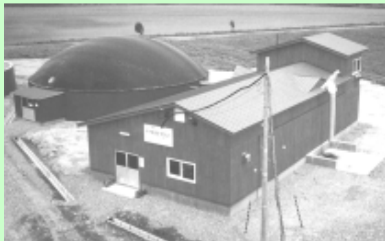
(写真)まちむら農場バイオガスプラント
