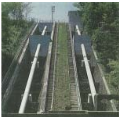
(写真) 水圧管路 (資料) 札幌市水道局
