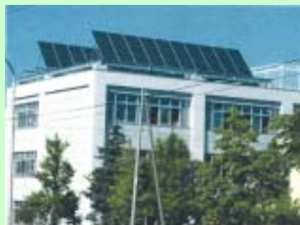
（写真）札幌市立美しが丘小学校に設置された太陽光発電が全校の使用量の10%弱を賄う
